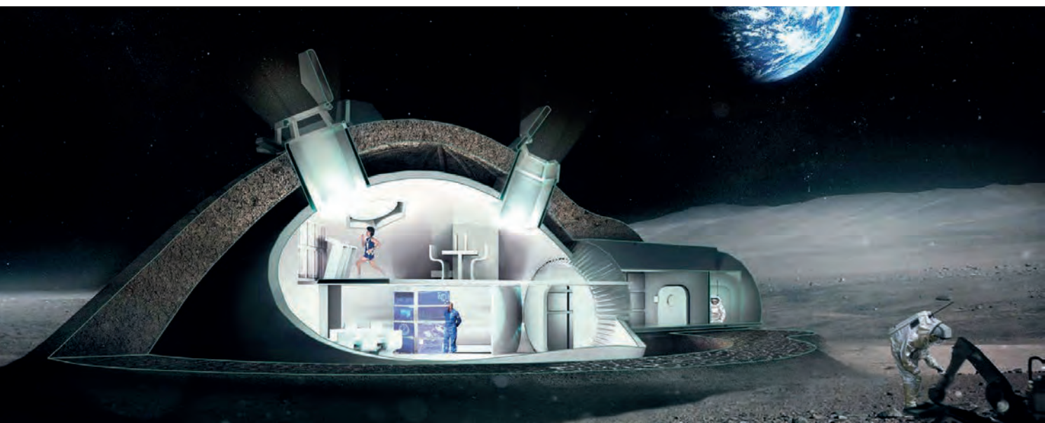
Проект лунной базы для четырех человек. Основание разворачивается из трубчатого модуля и надувного купола. Затем над куполом наращиваются слои реголита с помощью 3D-принтера. © ESA
