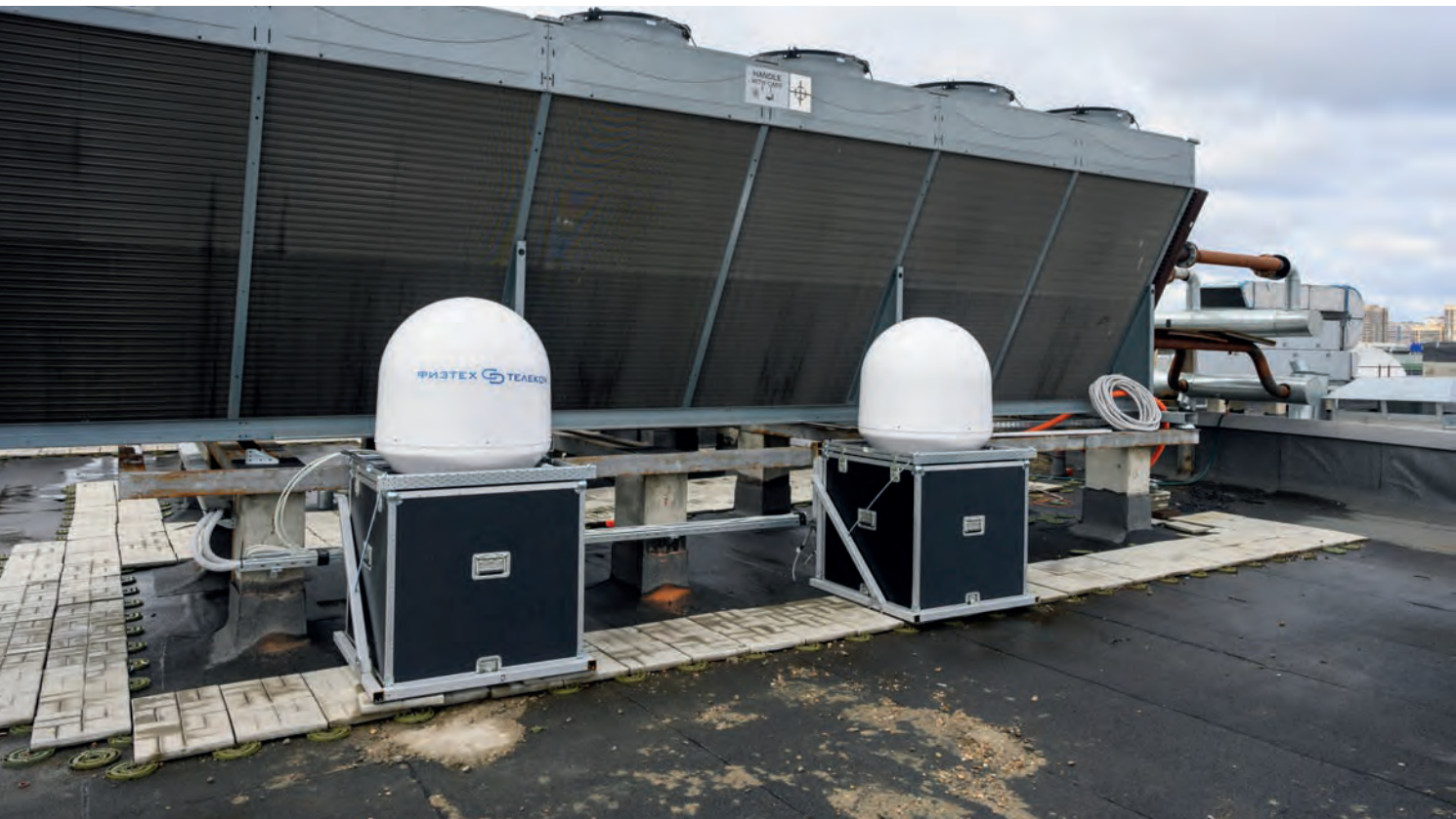
Тест-зона на крыше корпуса «Физтех.Арктика»
